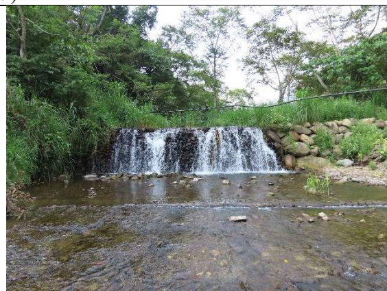
施工起點高壩
