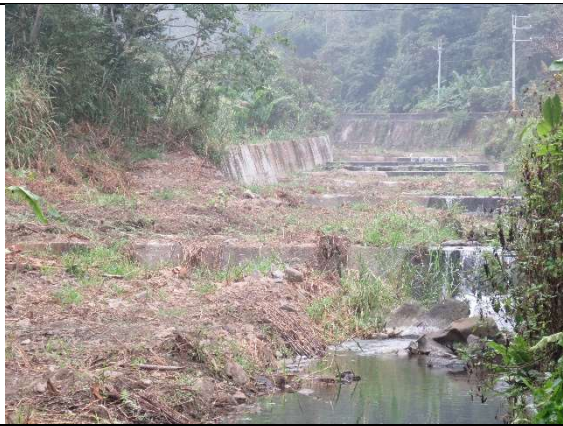
數處既有固床工
