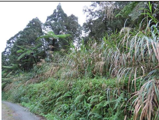
15K+300 林道上邊坡植被
