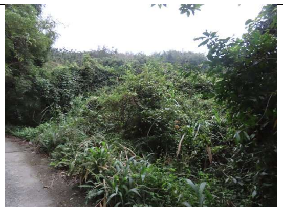
2K+400 林道下邊坡植被
