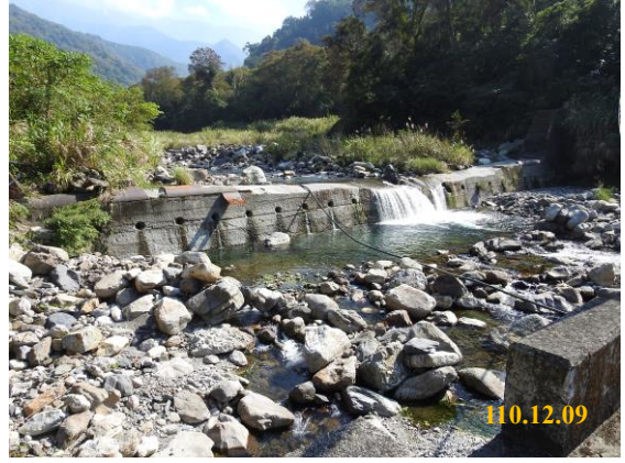
第1工區左岸植被
