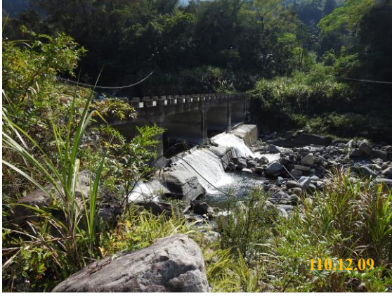
既有箱涵現況
