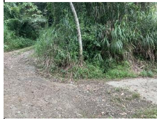
工區三集水井新設
