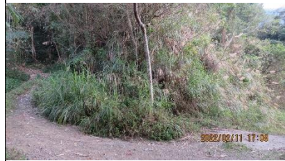
工區三集水井新設
