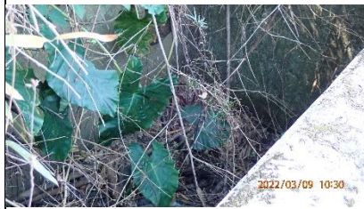
工區一既有集水井
