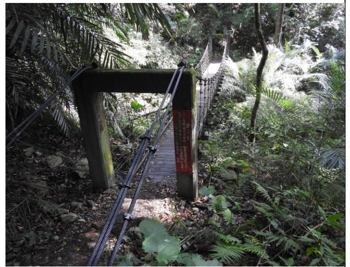
二號吊橋現況
