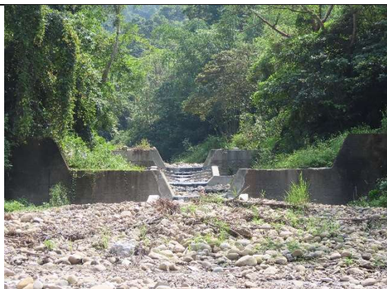
前期改善之固床工
