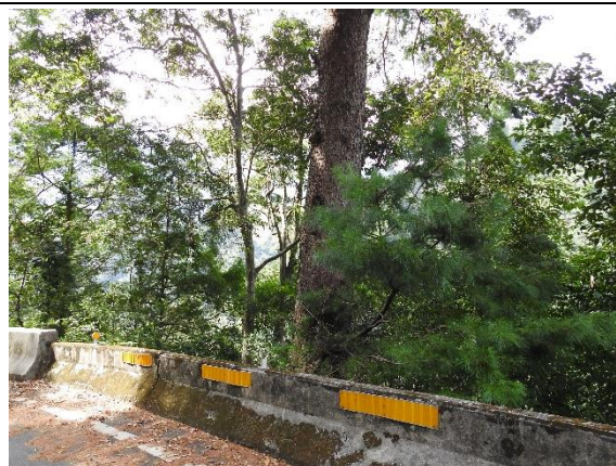
預計施作護欄加高
