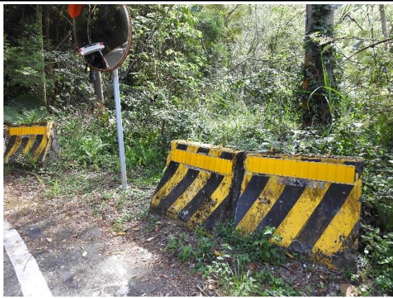
預計施作波狀護欄
