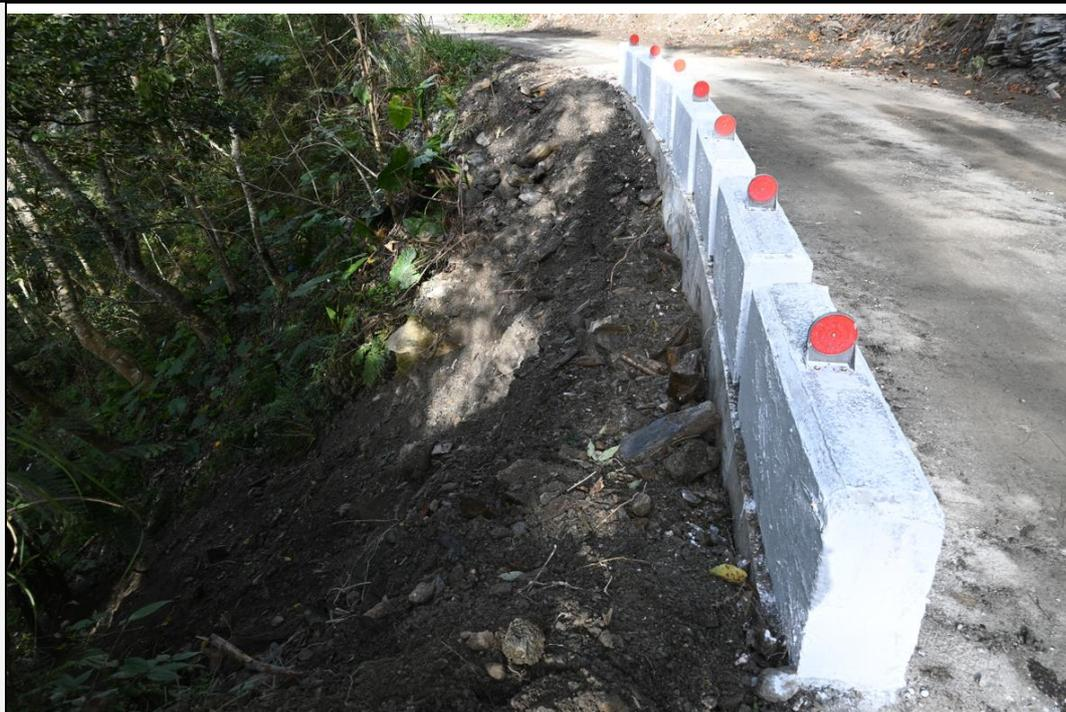
已將堆置於下邊坡的大型混凝土塊，按照解決對策進行改進，碎化至粒徑小於 20 公分進行回填，利於工程結束後，棲地植生的恢復 (拍攝時間:2023/12/25)
