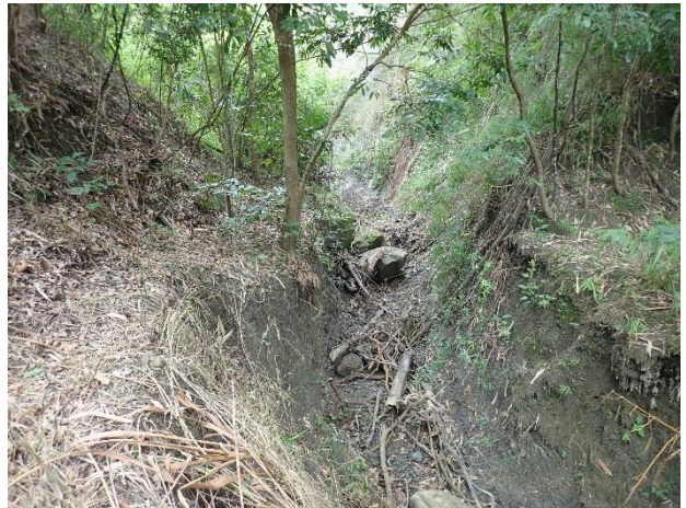
▲蝕溝沖刷坡腳造成邊坡崩坍
