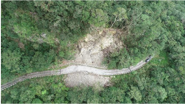
15.7K 崩塌地災害空拍圖 (2023/09/20)
