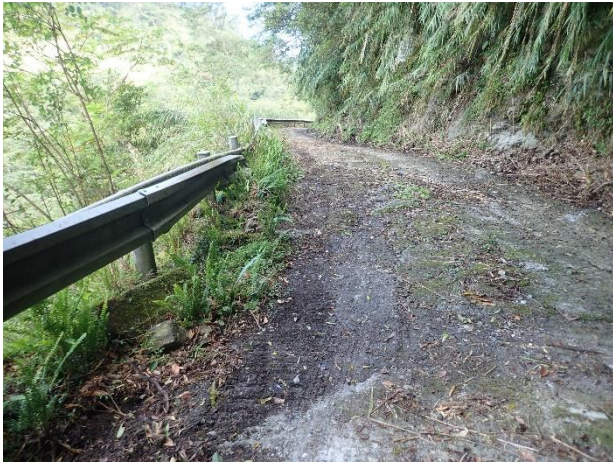
16.5K 路面整理 (2023/09/20)
