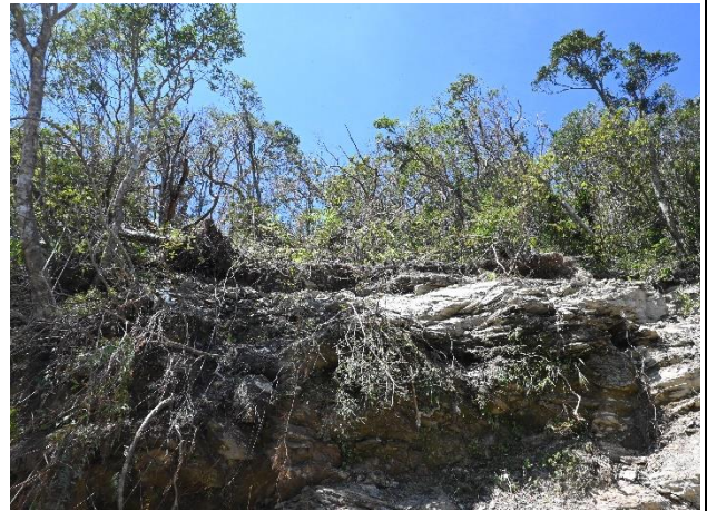
林道 8.5K 處崩塌坡面
