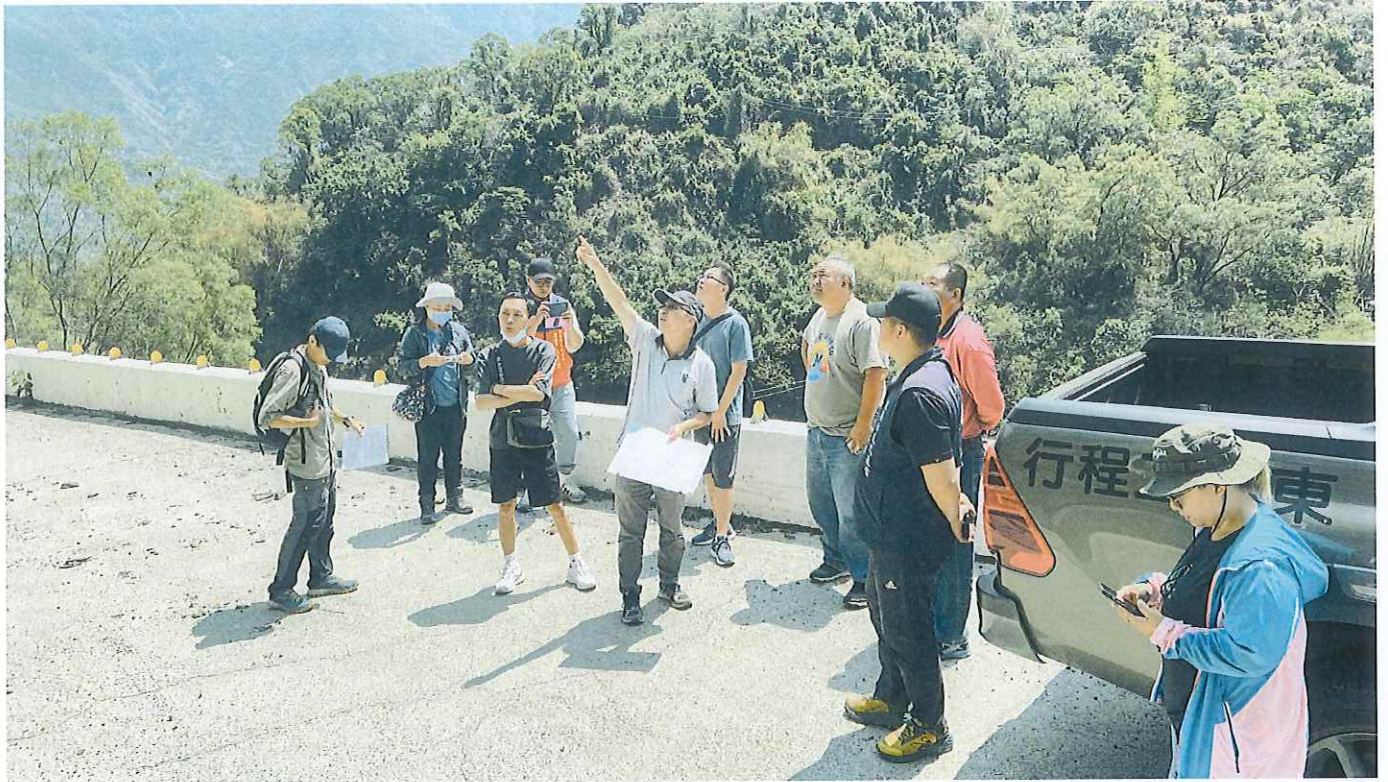
工地現地說明
