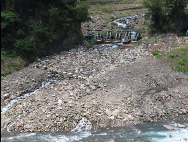
設立基樁與鋪排塊石 111.08.23
