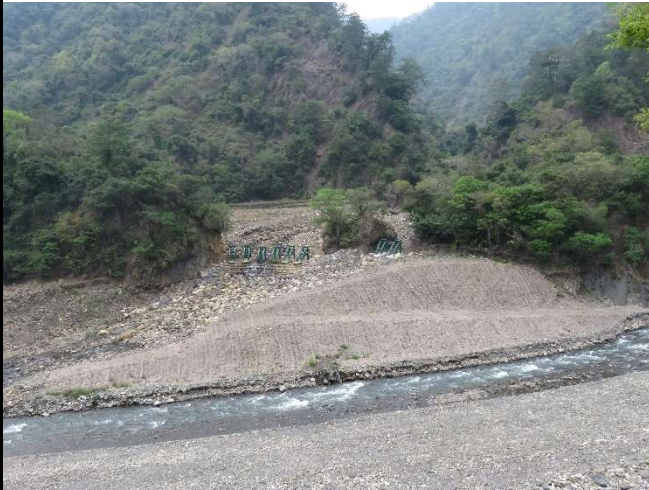
增加鋪排塊石及堆積清淤砂石 109.03.12
