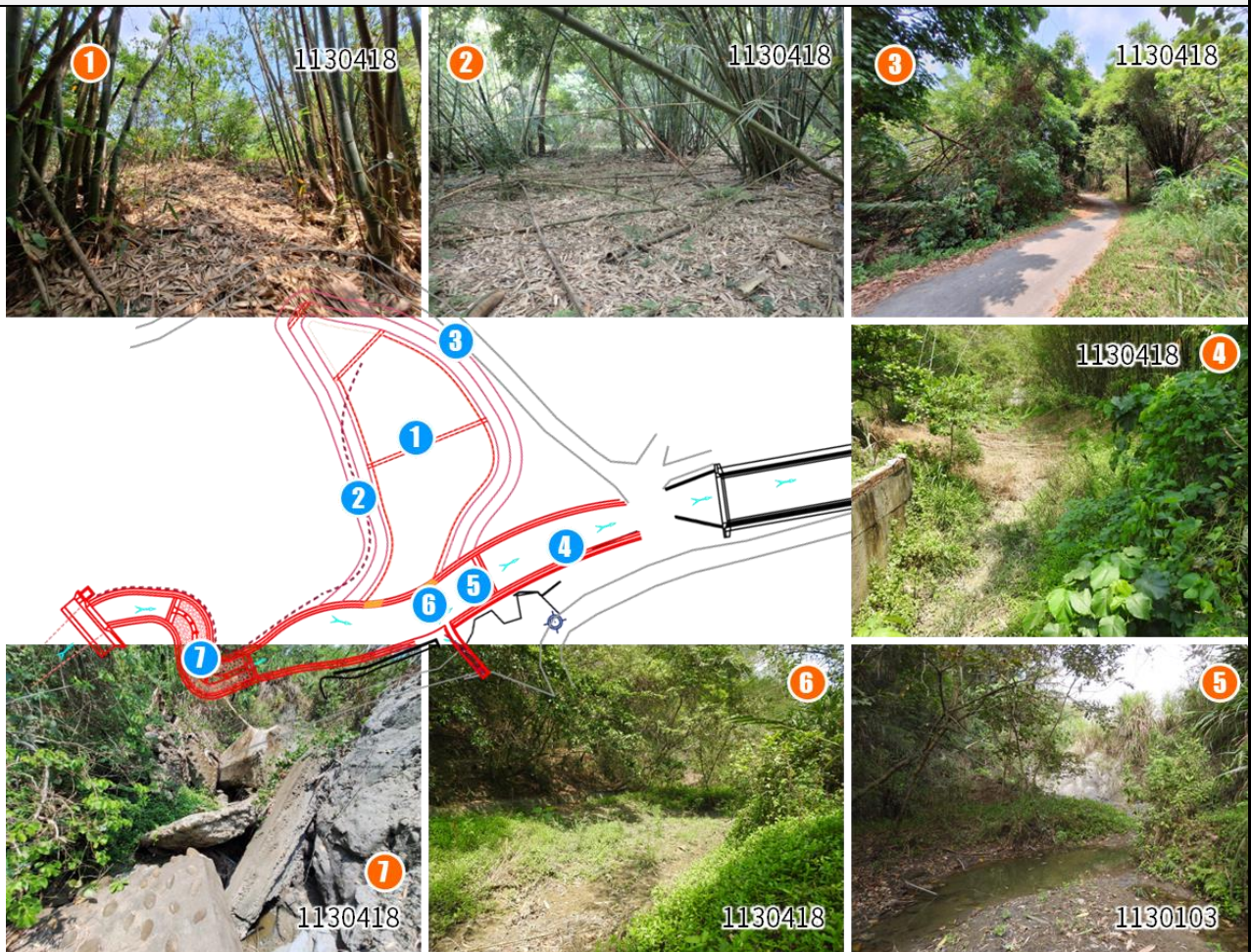
圖 區外保安林第 2007 號北勢坑等治理工程-環境照片
