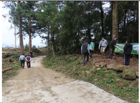
大湍林道既有混凝土鋪面
