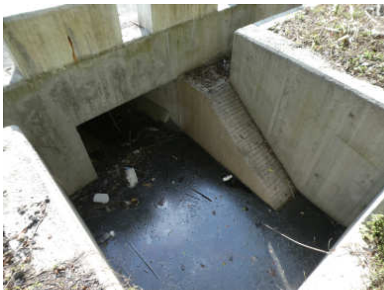
混凝土斜坡道
