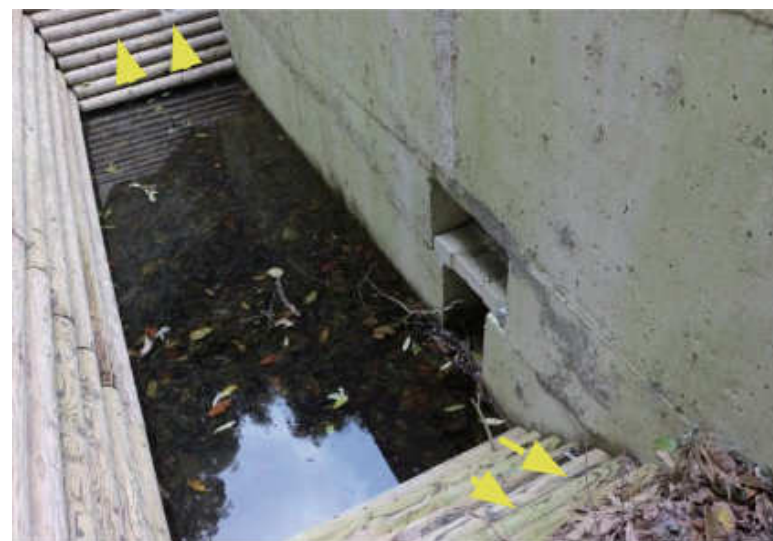
混凝土斜坡道，表面鋪設木材
