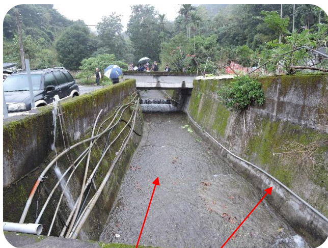
過往水泥固床 無孔隙
